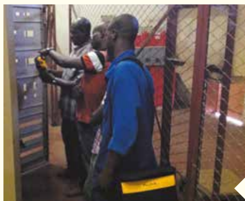
Formation service technique de l'hôtel AZALAI SALAM Module : Prise en main caméra infrarouge pour l'inspection des équipements et installations.
