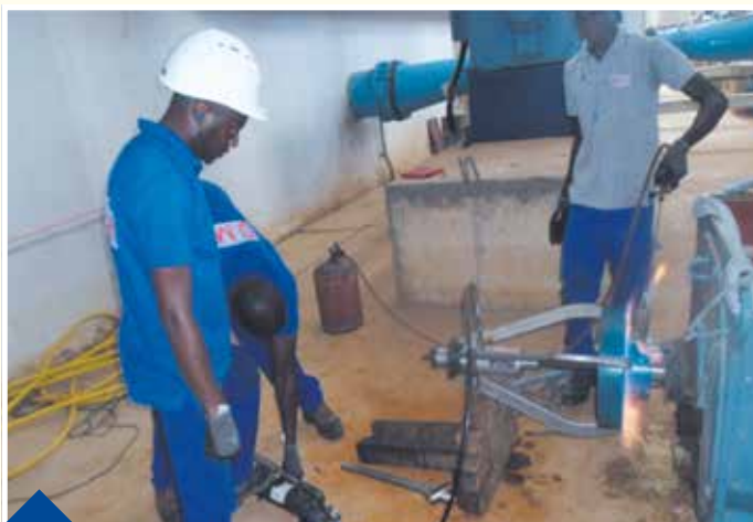
DEMONTAGE: Dépose de l'accouplement du moteur
