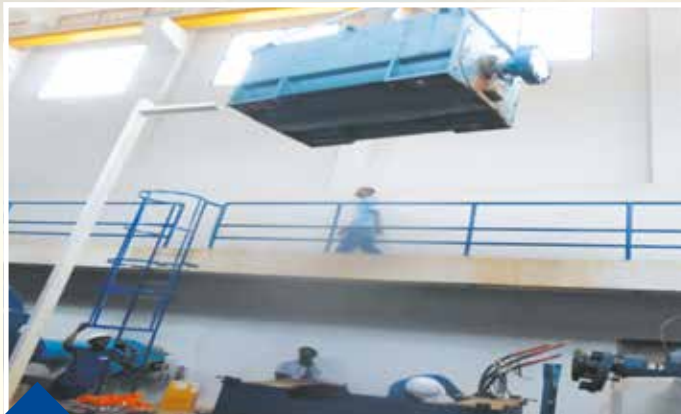
DEPOSE : - Déconnexions câbles et boulonnerie - Dépose du moteur
