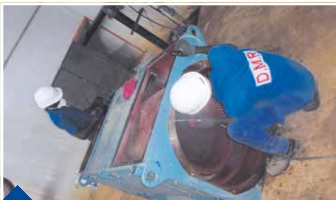
ENTRETIEN DU MOTEUR : Nettoyage des enroulements avec du solvant diélectrique
