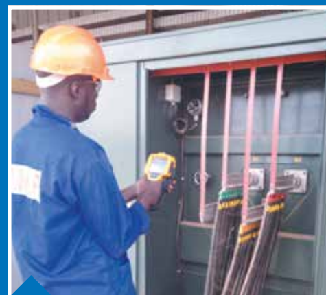
Inspection des installations électriques par la thermographie infrarouge.
