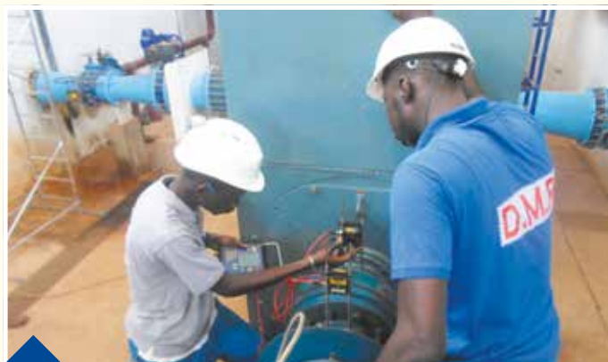
LIGNAGE AU LASER : Lignage moteur / pompe avant mise en service
