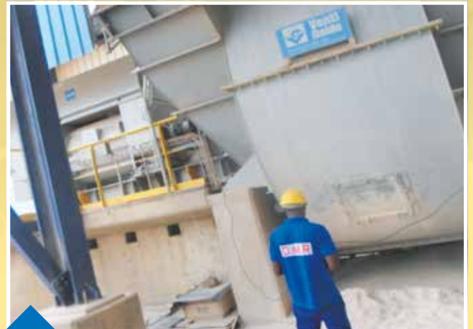
Equilibrage sur site turbine 345FN280M02 Diamètre : 2916mm ; Vitesse 990tr/mn CLIENT : CIMENTS DU SAHEL (Sénégal DAKAR)
