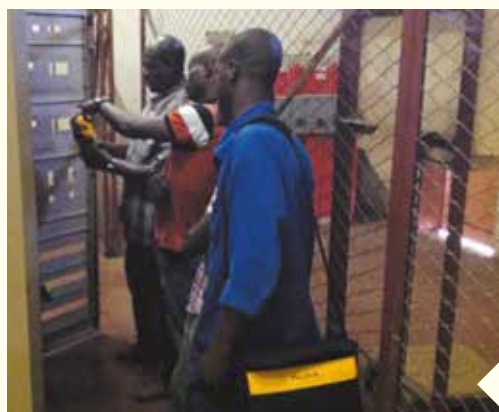
Formation service technique de l'hôtel AZALAI SALAM Module : Prise en main caméra infrarouge pour l'inspection des équipements et installations.
