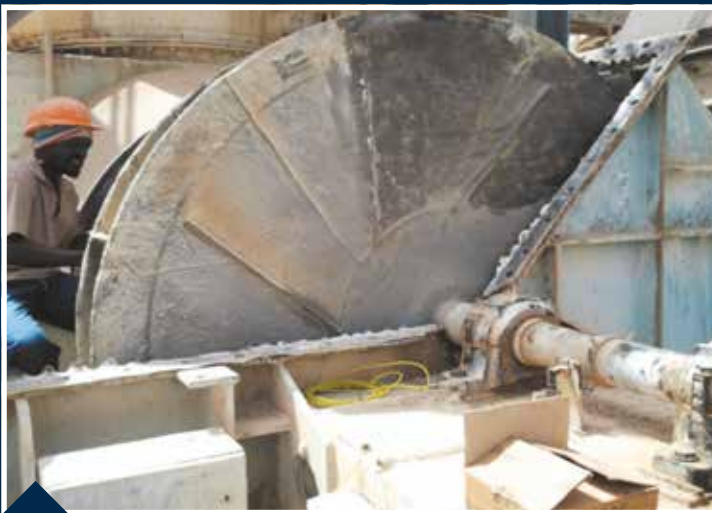
Equilibrage sur site ventilateur assainissement C2818 Diamètre : 2000mm ; Vitesse : 927tr/mn CLIENT : ICS (Sénégal DAKAR)
