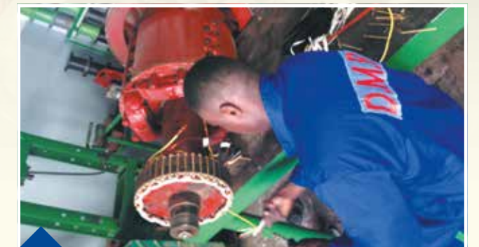
Rebobinage induit excitation Alternateur 1250 KVA 400V - CLIENT : MATFORCE
